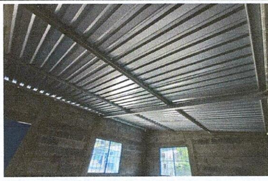
Foto 6: Sustitución cubierta de techo a lámina troquelada calibre 26 e instalación de estructura metálica
