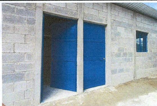
Foto 5: Instalación de puertas metálicas
